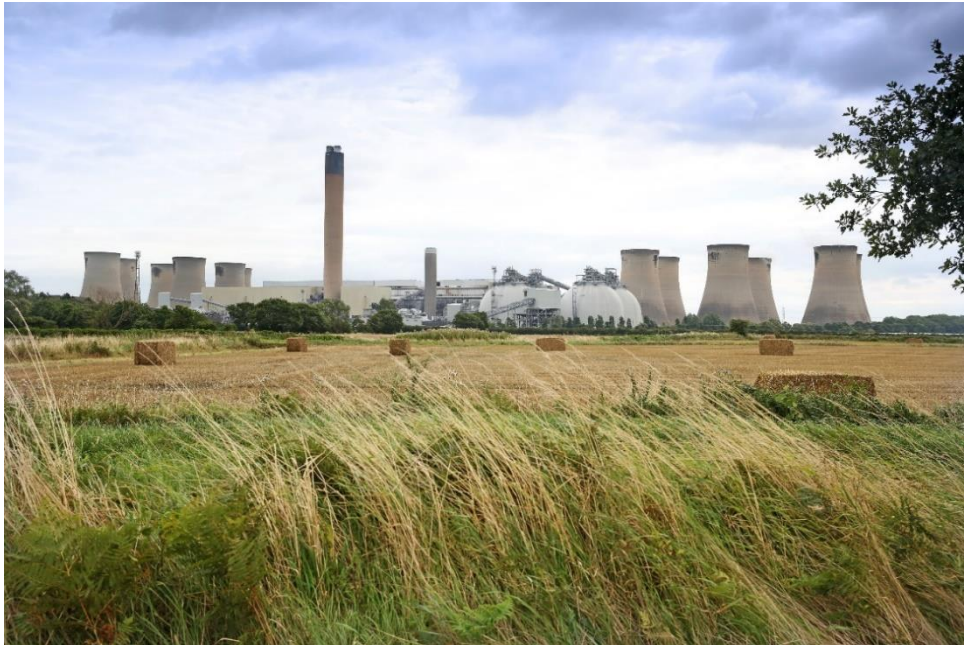
Figuur 33: De Drax-centrale in Selby, Verenigd Koninkrijk; de opslagkoepels voor biomassa zijn te zien (Bron: Drax Group)
