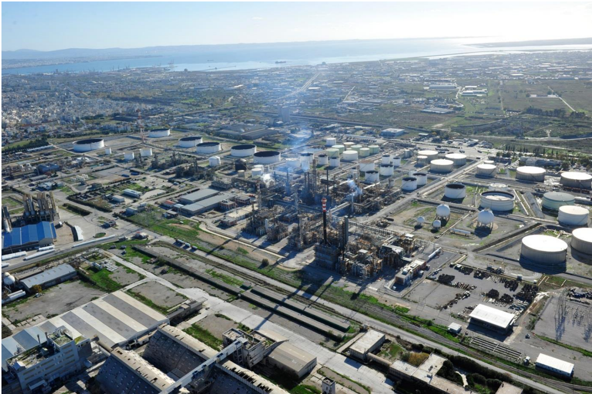
Figuur 21: Fossiele raffinaderijen zijn grote industriële complexen waar een groot aantal verschillende fossiele brandstoffen en andere producten geproduceerd worden. (Foto: Thessaloniki Refinery, Hellenic Petroleum)
