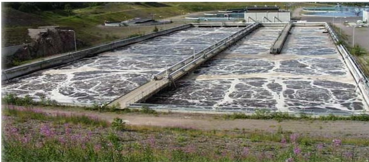
Figuur 43: Actief slibproces dat organische componenten uit afvalwater verwijdt (KnowPulp, 2019)
