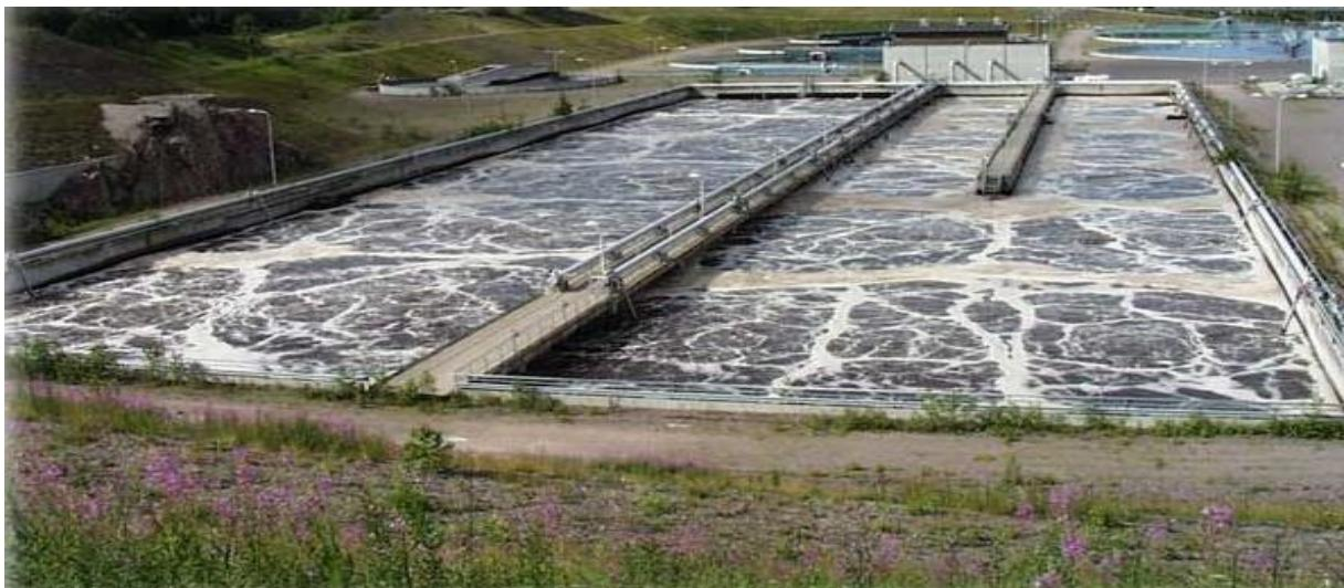
**Slika 34:** Proces aktivnog mulja koji uklanja organske komponente iz otpadnih voda
