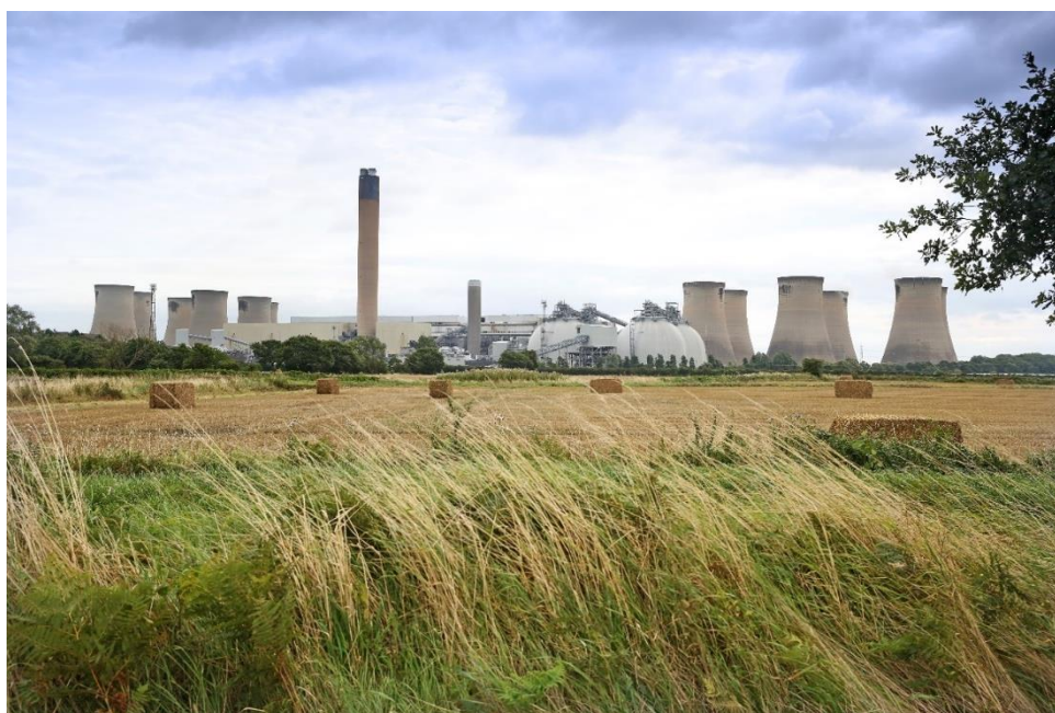
Figura 33: Central eléctrica de Drax en Selby, Reino Unido; las cúpulas de almacenamiento de biomasa son visibles (Fuente: Drax Group )
