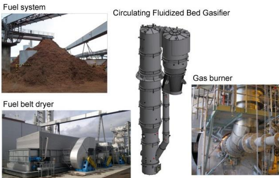
Εικόνα 50: Τμήματα μονάδας αεριοποίησης (Know pulp, 2019)
