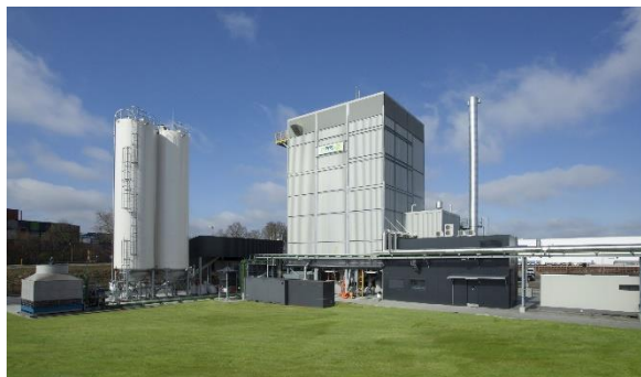
Εικόνα 29: Η μονάδα πυρόλυσης Empyro στο Hengelo της Ολλανδίας
