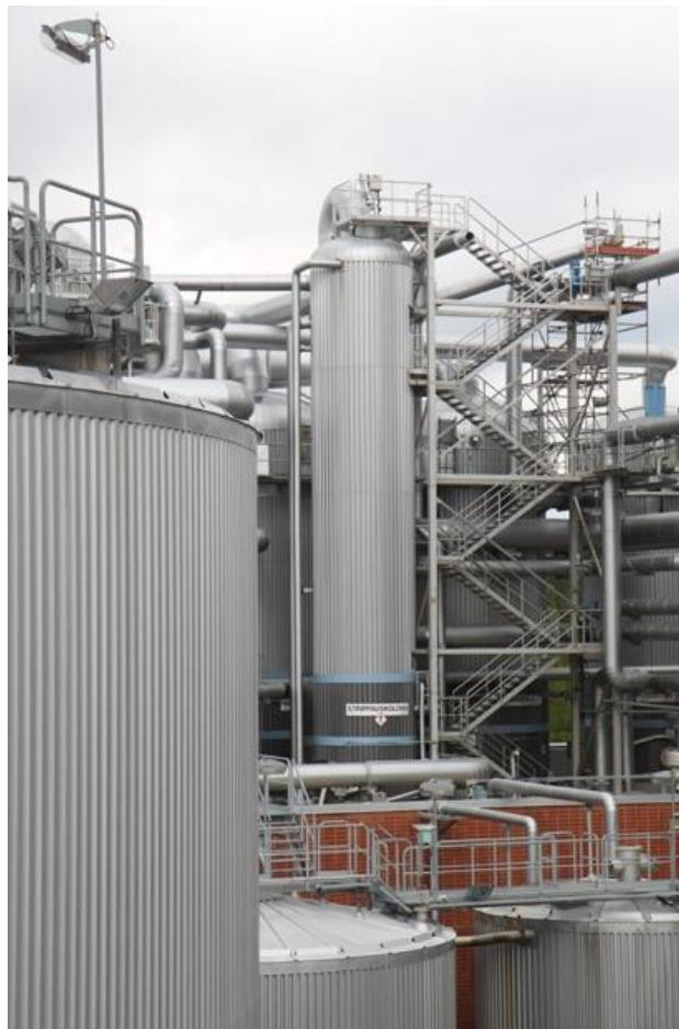
**Slika 44: Separacija etanola iz tvornice celuloze: spremnici i sistem za odvajanje kondenzata (KnowPulp, 2019)**
