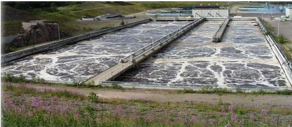
Slika 43: Proces aktivnog mulja koji uklanja organske komponente iz otpadnih voda (KnowPulp, 2019)
