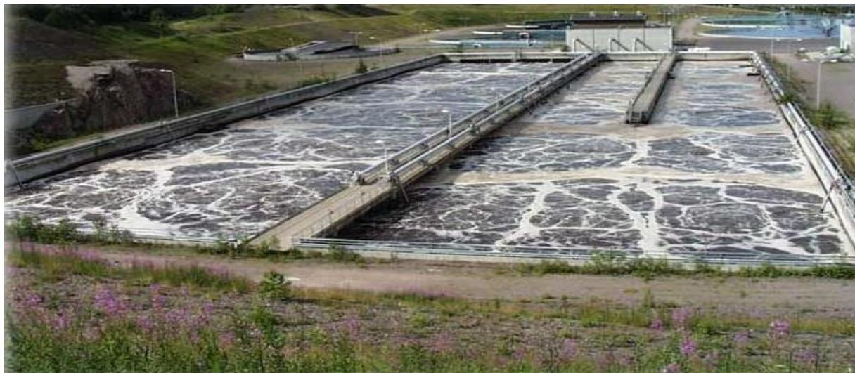
**Figura 44: Proceso de lodos activados para eliminación de los componentes orgánicos de las aguas residuales (KnowPulp, 2019)**
