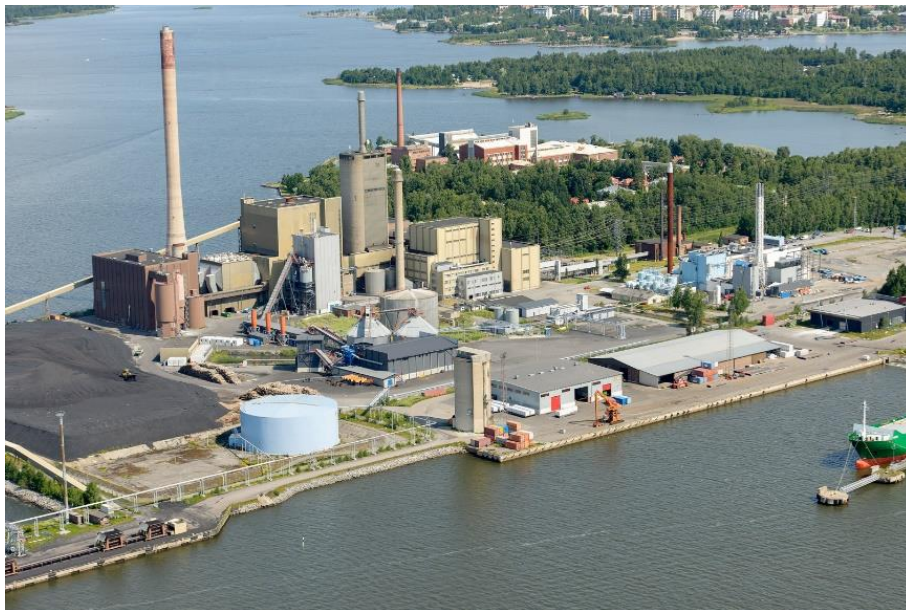
Vaskiluodon voimalaitoksella Vaasassa on käytössä metsähakkeen epäsuora rinnakkaispoltto. Metsähakkeen kaasuttimen kapasiteetti on 140 MW. (Kuva: Pohjolan Voima)
